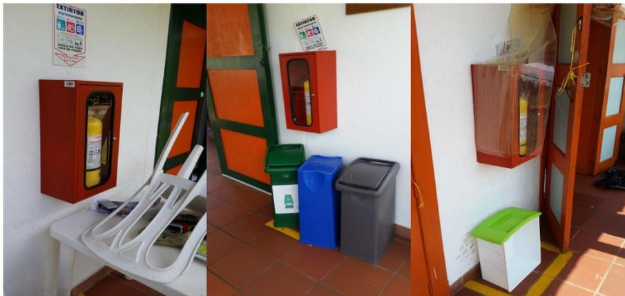
Gabinets con elementos para control de incendios con ausencia de piezas fundamentales que impiden su utilidad, elementos en mal estado o dañados, sin avisos de uso o con avisos en mal estado, incumpliendo la norma.
